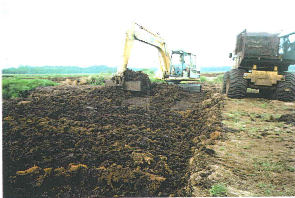
Saint-Laurent-de-Gosse (40). Exploitation hors d'eau à la pelle mécanique, évacuation par tombereau.
