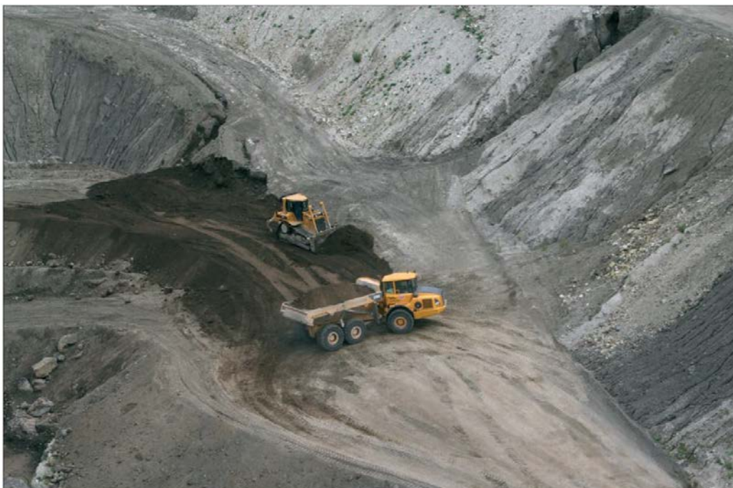
Figure 30 : Opération de décapage par bulldozer et tombereau sur le gisement de Foufouilloux (Cantal). Source : Mines & Carrières
