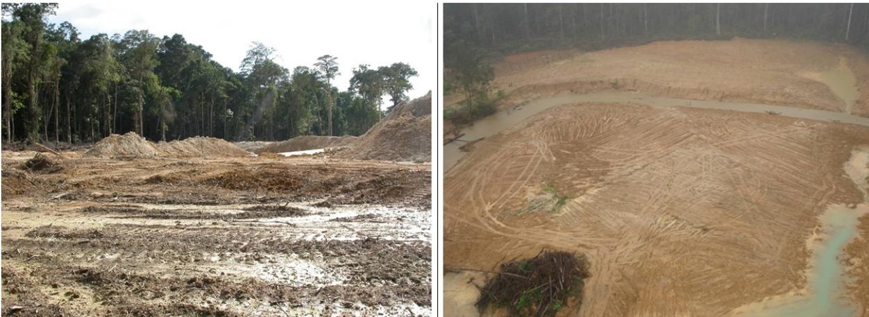
*Figure 27 : L'association de l'exploitant société ERMINA avec le biologiste PHYTOTROP, sur l'exploitation de Saint-Félix. Gauche : Le chantier en finition. Droite : La zone ré-égalée, re-profilée et replantée (Cliché : C. Pernaut).*
