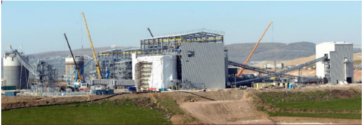
Figure 5 : Projet minier Hemerdon en construction (avril 2015). Vue sur l'usine de traitement. Mine d'étain-tungstène développée par Wolf Minerals Ltd. en Cornouaille au Royaume-Uni (active depuis septembre 2015).
