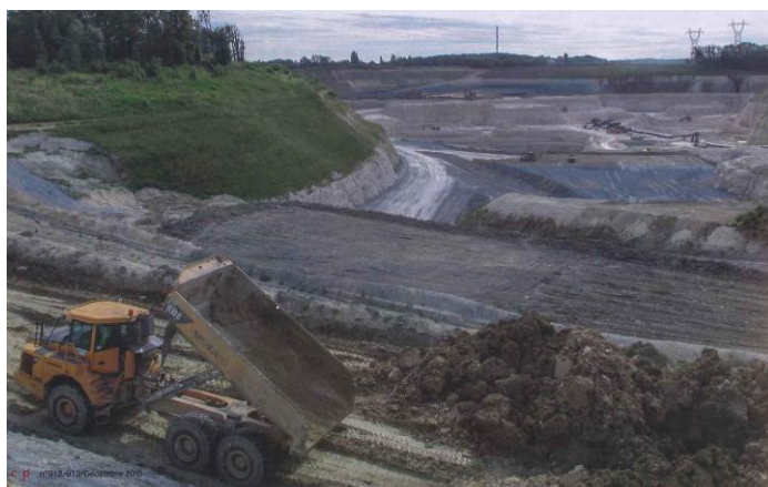
Carrière de gypse de Pin-Villeparisis (cliché Placoplatre)
