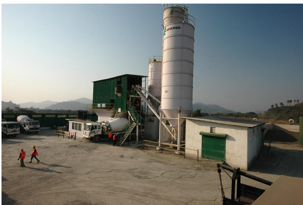
Centrale à béton prêt à l'emploi de Thane, région de Mumbai (Droit de reproduction : Lafarge DR, Photographe : Gerber Ignus, Lafarge ).
