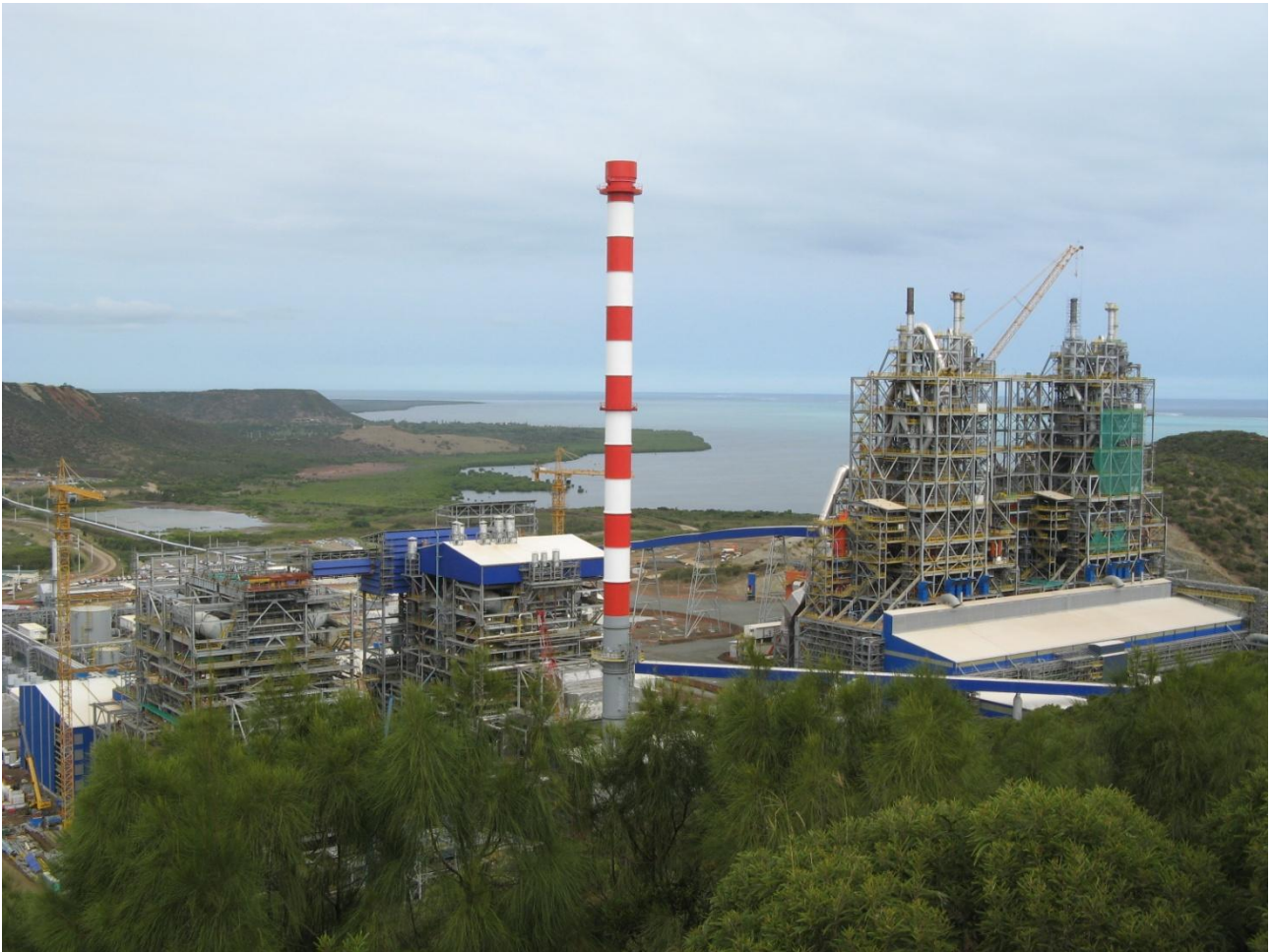
Le site industriel de Koniambo Nickel : la centrale thermique et, à droite, les 2 fours (Photo : Th. Augé)
