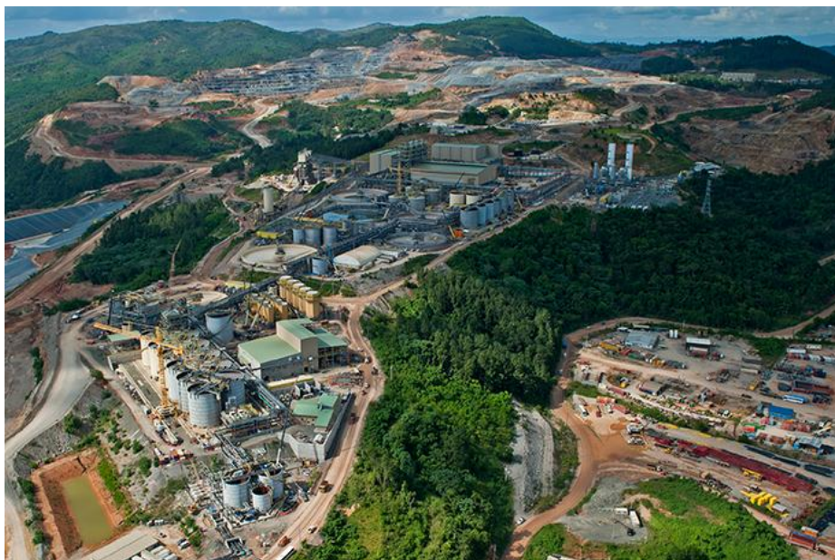
Usine de traitement du minerai de la mine Pueblo Viejo, (source : Barrick Gold Corporation )
