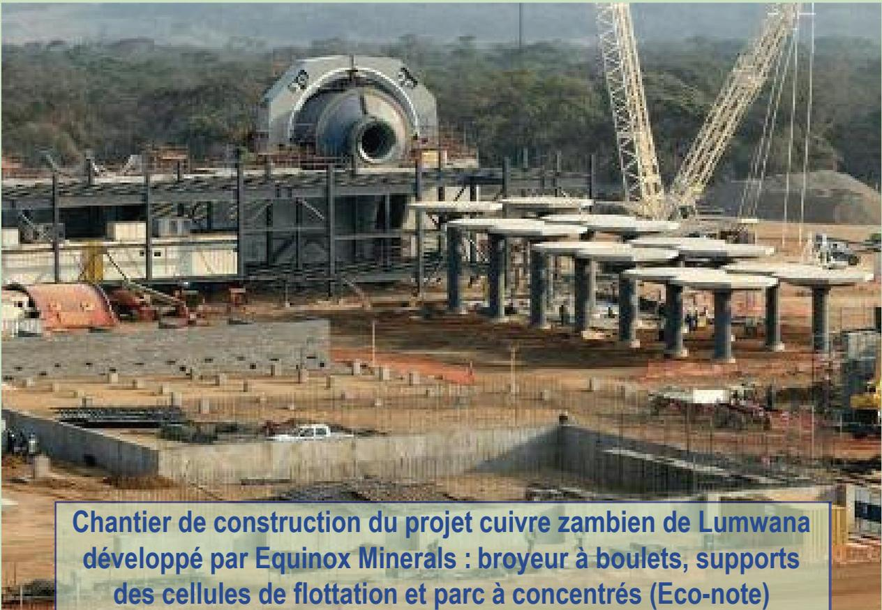
Chantier de construction du projet cuivre zambien de Lumwana développé par Equinox Minerals : broyeur à boulets, supports des cellules de flottation et parc à concentrés (Eco-note)
