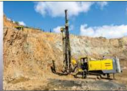
Mines et construction
