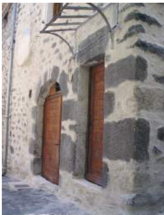
Rejointoiment de pierres brossé à la chaux NHL 3,5
