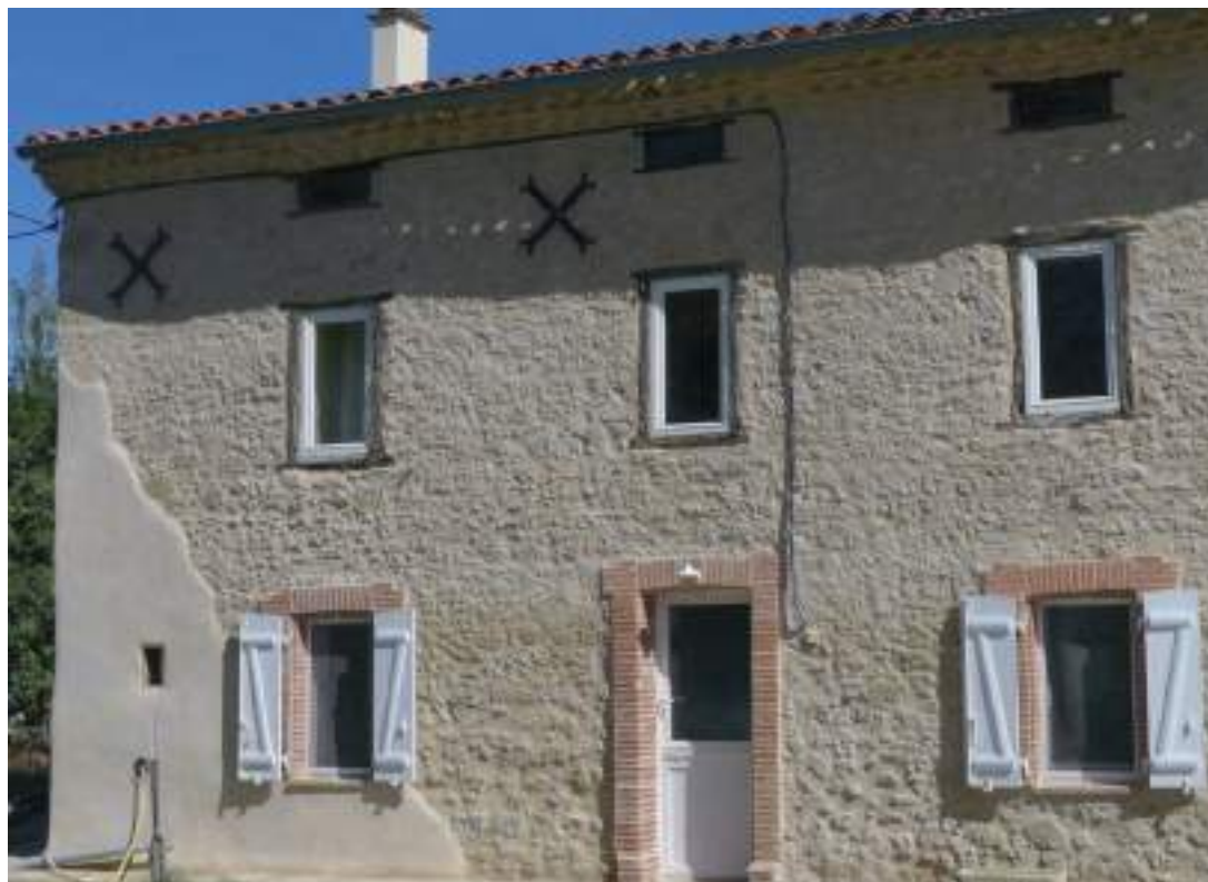
Maison du XVIII e à Saint-Julia (33), détails
