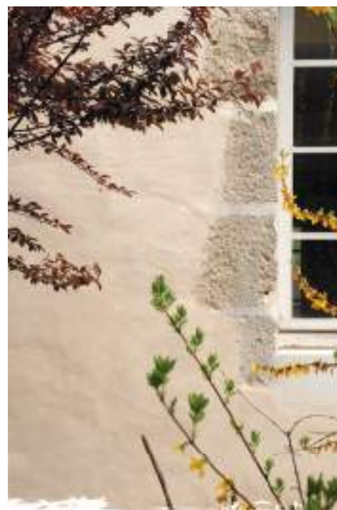
Enduits extérieurs, mortiers de chaux. Rénovation lycée Jacques Amyot, Auxerre (89)
