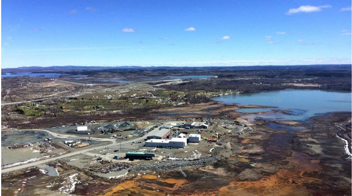
Figure 49: Futur site de construction des installations de la mine Horne 5 (source : miningweekly.com )
