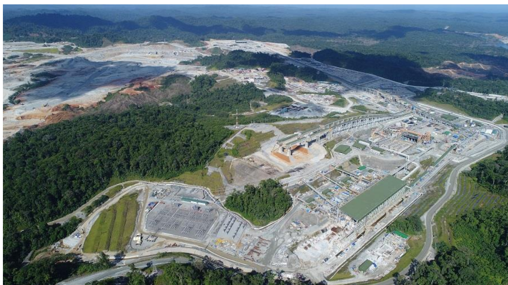
Figure 46 : La mine de Cobre Panama et son usine de traitement (© First Quantum).
