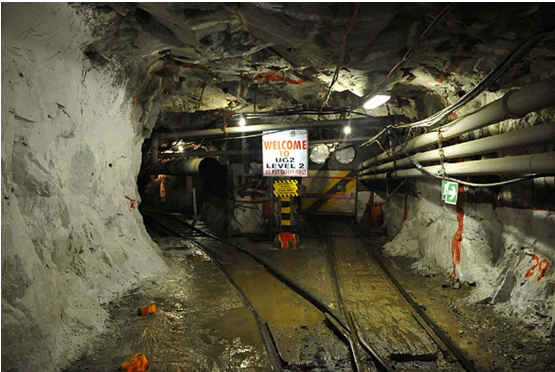
Figure 75 - Galerie de la mine souterraine de Bakofeng-Rasimone au niveau de l'UG2 reef. (© www.bakofengplatinum.co.za ).
